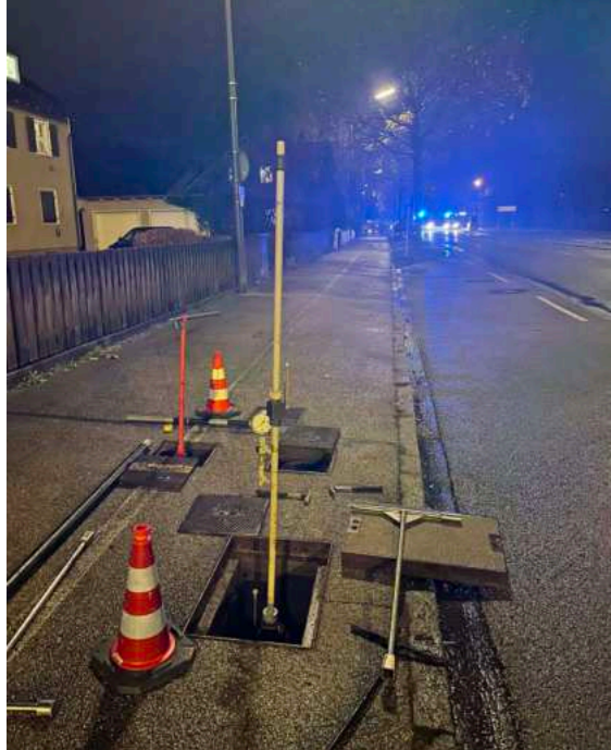
Druckentlastungsöffnung an der Planegger Straße
