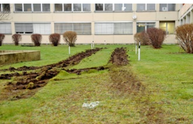
Aufgrund von Humusbildung nicht mehr nutzbare Aufstellfläche – der zweite Rettungsweg kann nicht mehr hergestellt werden und eine Anleiterbereitschaft für vorgehende Trupps im Innenangriff ist nicht mehr möglich.
