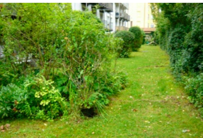
Durch Bewuchs nicht mehr erkennbare und nicht mehr nutzbare Aufstellfläche für Hubrettungsfahrzeuge.
