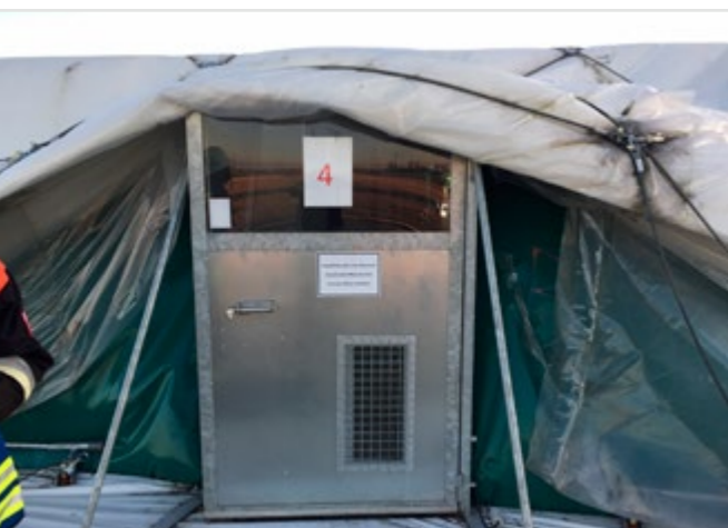
Bild o.: Die Stützstruktur der Halle hielt die Fluchtwege offen. Bild u.: Der westliche Notausgang war durch die abgesenkte Hülle von außen so blockiert, dass er sich nicht öffnen ließ.
