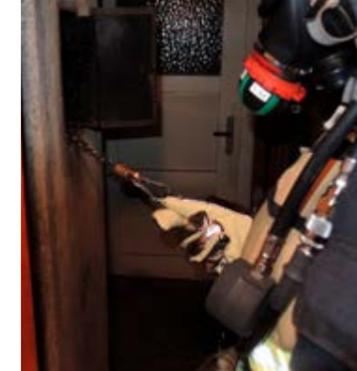
Reinigung des Schornsteins von der oberen Reinigungsöffnung mit dem Werkzeugsatz »Schornsteinfeger«
