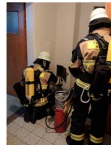
Entnahme der Rückstände aus dem Schornstein an der unteren Reinigungsöffnung
