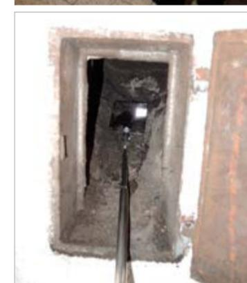
Kontrolle des Schornsteininneren mit dem Teleskopspiegel auf freien Querschnitt
