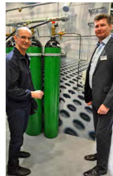
Brandrat Stephan Gräser BF Nürnberg (li.) und Markus Kock von der Firma Wagner rechts schauen sich die Stickstoffflaschen an, mit denen der Sauerstoff in Räumen verdrängt wird.
