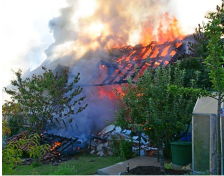
Westseite des Hauses: Vollbrand beim Eintreffen der Einsatzkräfte, die Außenwand fehlt nach der Explosion.
