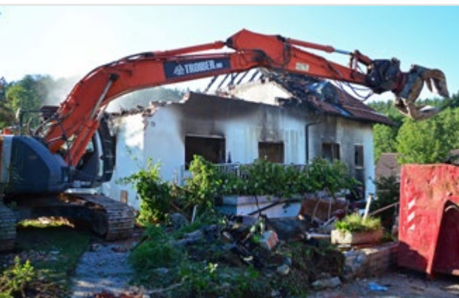
Bild o.: Blick von der »Bastelkammer« ins Freie, nach weggesprengter Außenmauer, in der Mitte eine der geborstenen Gasflaschen; Bild u.: Trotz der behutsamen und gefährlichen Abbrucharbeiten wurde das Abbruchmaterial in mehrere Container sortiert.
